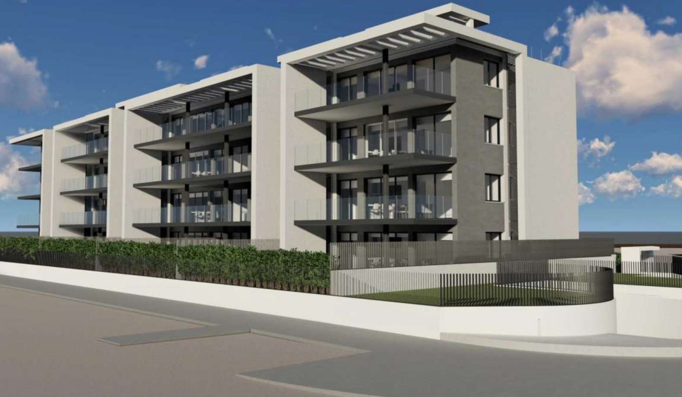
Nouveau rez-de-chaussée en construction sur la plage Arenal de Jávea MONTAÑAR - EL ARENAL, JÁVEA/XÀBIA - REF. B0-A
