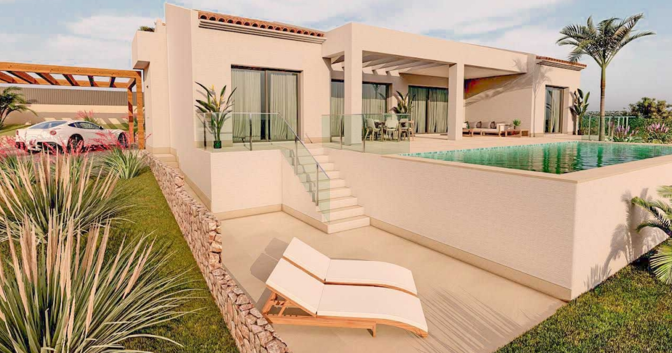
Villa en construction à Las Laderas , Jávea PARTIDA COMUNES - ADSUBIA, JÁVEA/XÀBIA - REF. V-517
