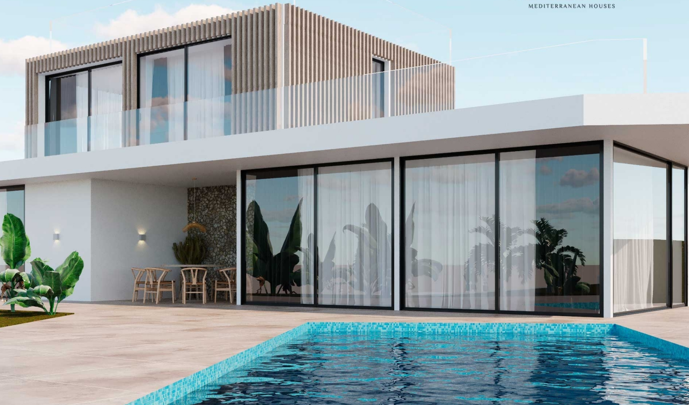
Villa en construcció en Cap Marti-Tosalet PARTIDA COMUNES - ADSUBIA, JÁVEA/XÀBIA - REF. V-502
